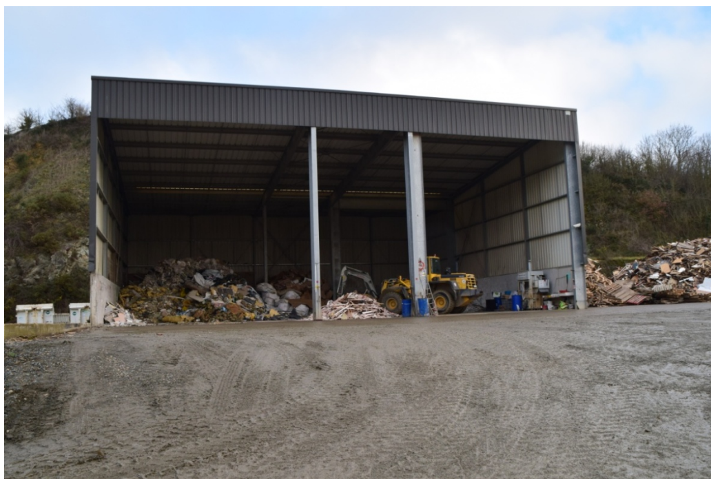
Hangar de stockage du papier/carton
